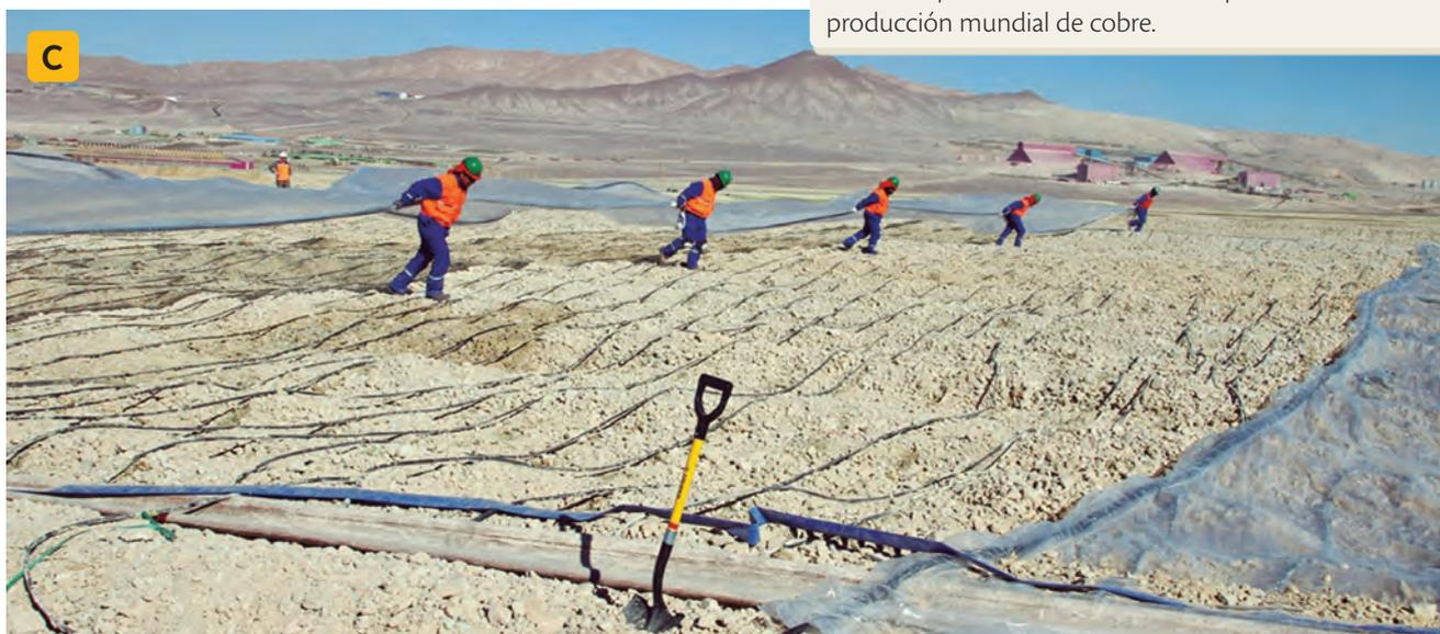
↑ Instalación de termofilm. Estas láminas permiten ahorrar agua en los procesos productivos de la minería del cobre.
